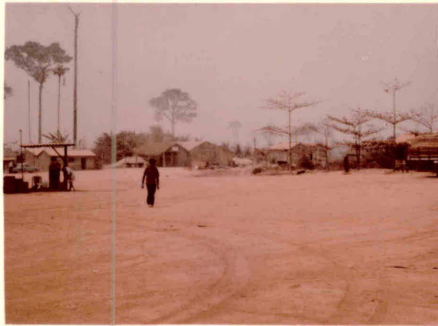
Figura III.81 - Aspecto da cidade de Ariquemes.
